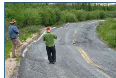
Dégradation du permafrost, route de Dempster - Canada
