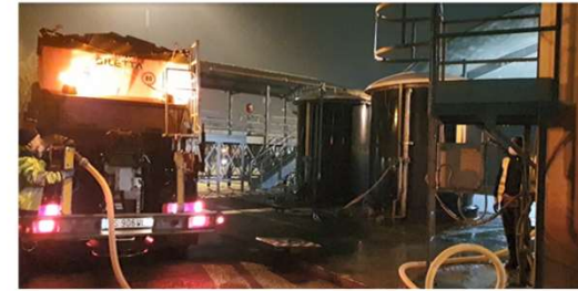
Figure10.1: Chargement d'une épanduse mixte dans une unité de fabrication de saumure à Turin
