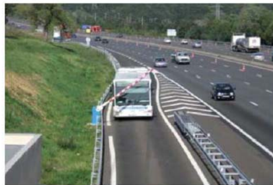
Arrêt de cars sur A10, Briis-sous-Forges (VINCI Autoroutes)
