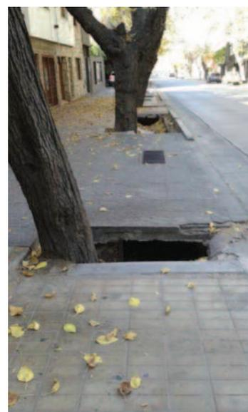
*Des précipitations rares mais parfois intenses canalisées par un réseau pluvial implanté dans les trottoirs, collecte des eaux et irrigation des arbres.
