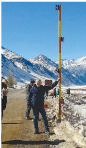
*Chaussée en béton en altitude (3200 m) et jalon de 4 m adapté à la hauteur des chutes de neige.*
