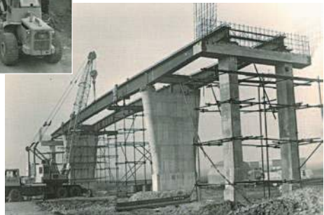
Construction à Douains - Tablier ossature mixte
