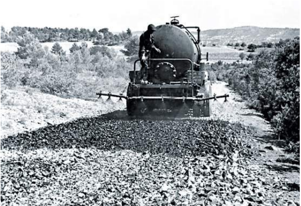
Route en macadam - Répandage d'émulsion, Années 50 (Colas)
