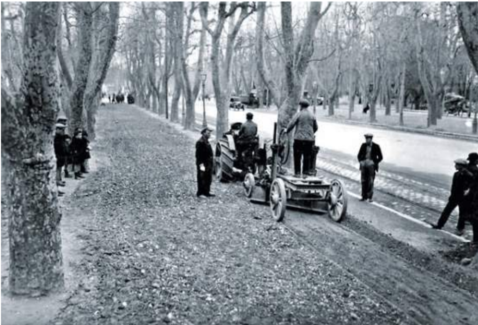
Niveleuse tractée, Marseille 1922 (Colas)
