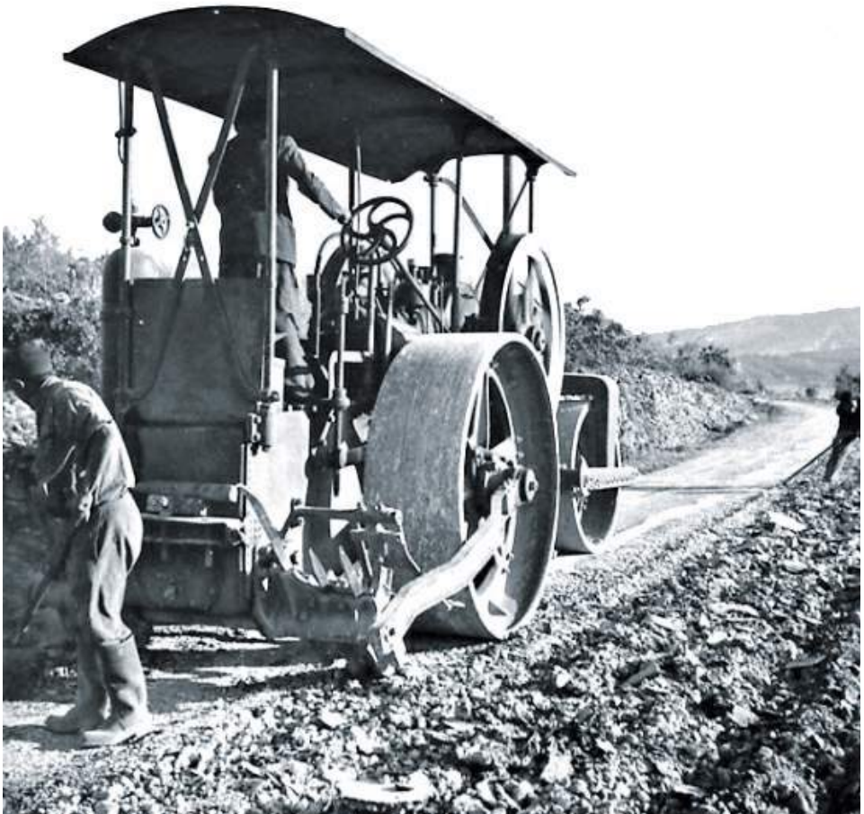
Route en macadam - Défonçage, Années 50 (Colas)
